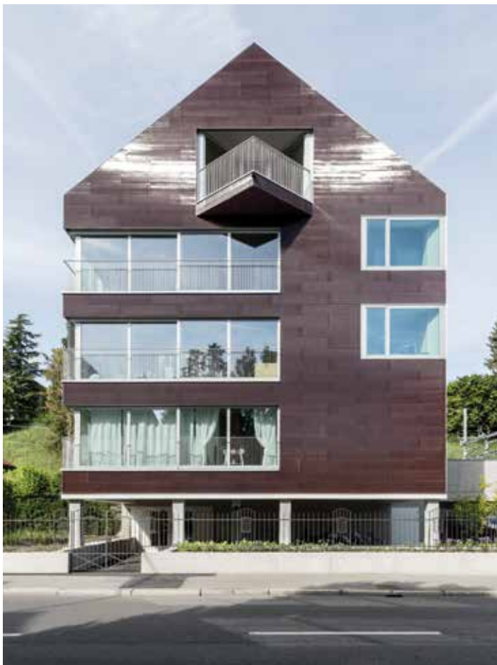
Abbildung 4.37: Das Wohnhaus Solaris in Zürich-Wollishofen von huggenberger-fries zielt eine dunkelrote PV-Fassade. (Foto: Beat Bühler)
