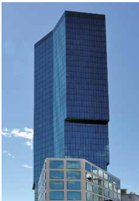
Abbildung 2.25: Prime Tower in Zürich mit einer vollverglasten Vor- hangfassade.
