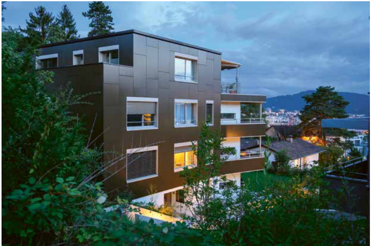
Abbildung 1.24: Das ganz in Photo- voltaik gehüllte Plusenergie- Mehrfamilienhaus in Zürich-Höngg. (Quelle: Kämpfen für Architektur AG)
