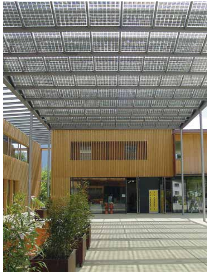
Abbildung 4.38: Vorplatzbeschattung mit PV-Modulen, Gemeindezentrum Ludesch, Österreich. (Foto: Ertex Solar, Amstetten, Österreich)
