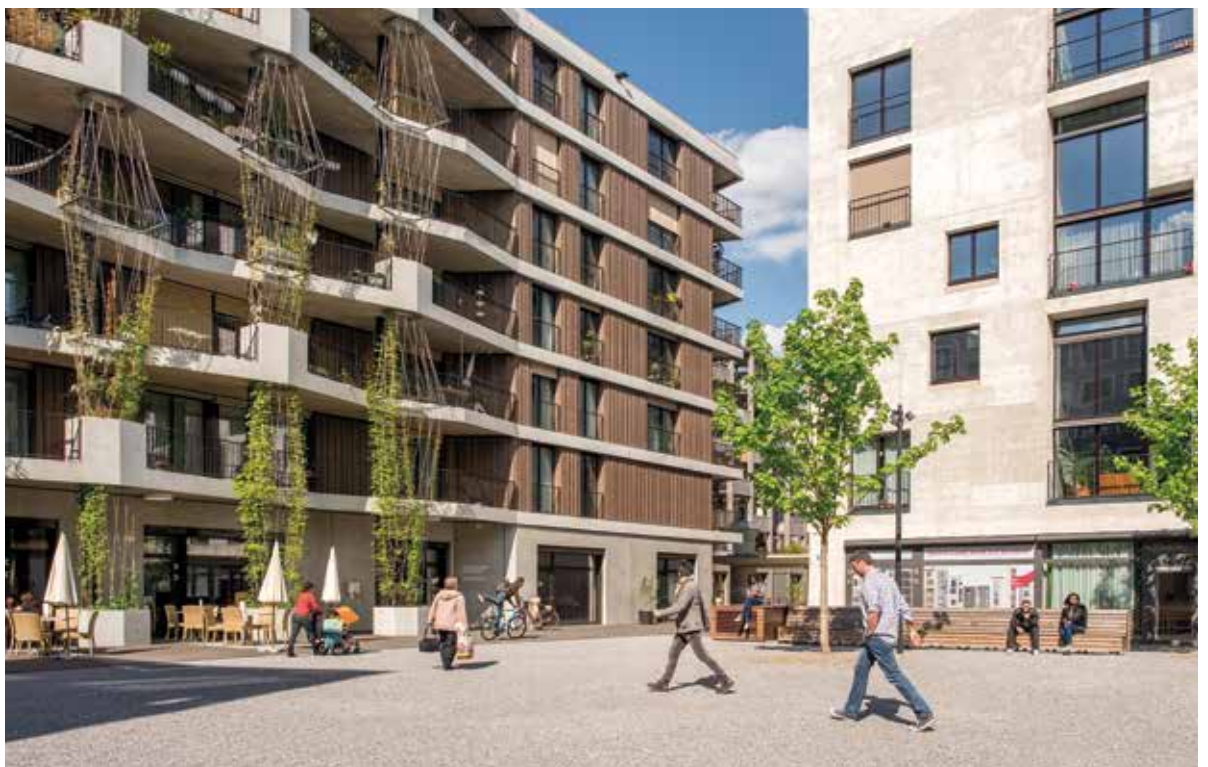
Abbildung 1.11: Hunziker-Areal in Zürich-Nord – Nutzungsmix belebt das Quartier. (Quelle: 2000-Watt- Areal, Energie- Schweiz)
