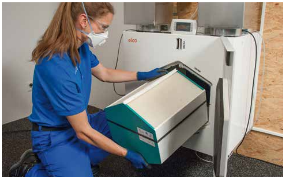
Abbildung 4.7: Wartung eines Komfortlüftungs- geräts. (Quelle: Kaminfeger Schweiz)
