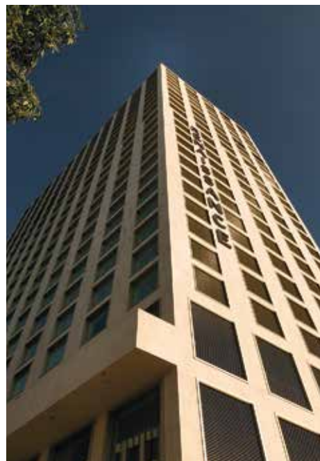
Abbildung 2.26: Mobimo Tower in Zürich – Vorhang- fassade mit Loch- fassadenoptik.
