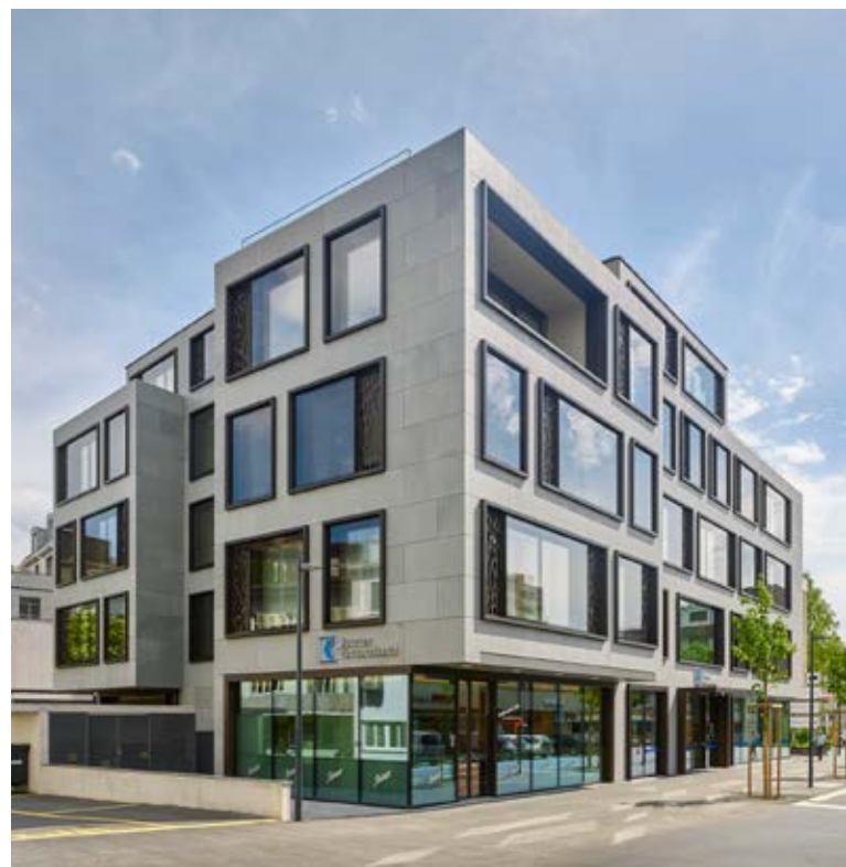
Die Filiale der Zürcher Kantonalbank in Uster wurde nach dem Minergie-ECO-Standard neugebaut und verfügt über eine Wärmeerzeugung mit Erdsonden-Wärmepumpe. Ein Teil des Stroms wird durch die eigene Photovoltaikanlage und ein Teil des Warmwassers durch Sonnenkollektoren erzeugt. Foto: Markus Fischer, Uster.
