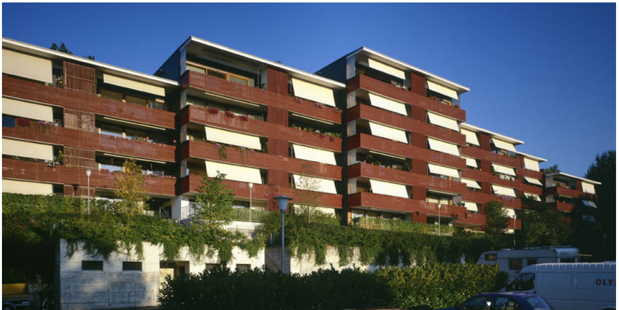
Abbildung 46: Bild vom Gebäude des Anlagenbeispiels (Bildquelle, Lemon Consult AG aus (Muller, et al., 2016))
