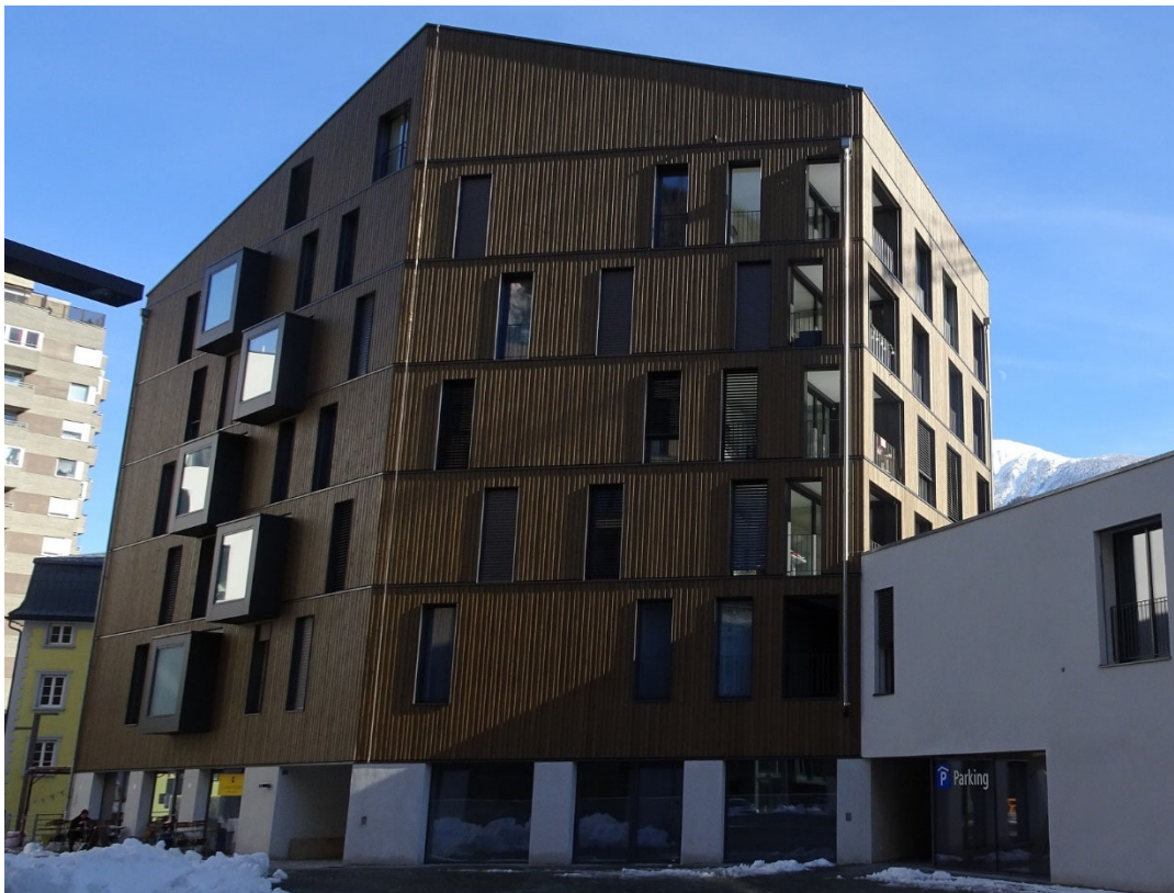
Abbildung 41: Bild vom Gebäude des Anlagenbeispiels (Bildquelle: HSLU)
