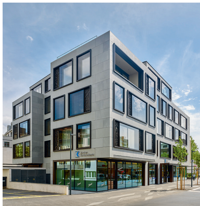
Die Filiale der Zürcher Kantonalbank in Uster wurde nach dem Minergie-ECO-Standard neu gebaut und verfügt über eine Wärmeerzeugung mit Erdsonden-Wärmepumpe. Ein Teil des Stroms wird durch die eigene Photovoltaikanlage und ein Teil des Warmwassers durch Sonnenkollektoren erzeugt. Foto: Markus Fischer, Uster
