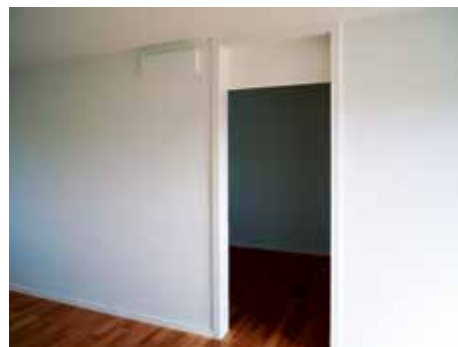
Le ventilateur mixte transporte l'air de la chambre à coucher dans le séjour.
