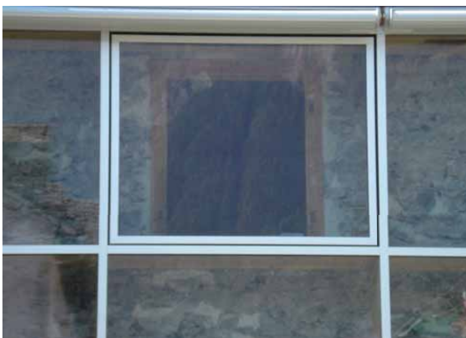
Abbildung 54: Durchblick in der «Doppelfassade».
