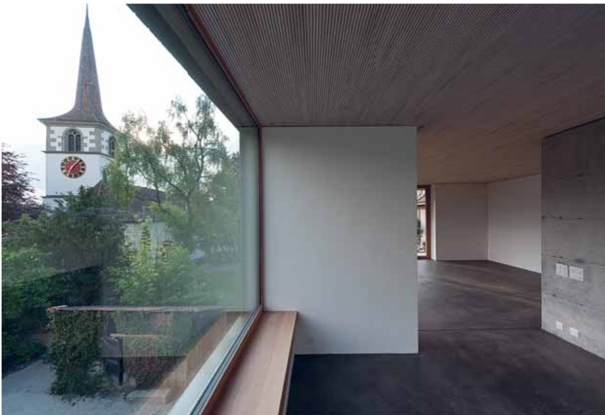
Abbildung 126: Auf dem Sockelgeschoss aus Recyclingbeton wurde eine Holzständerkonstruktion errichtet (Bild: Christine Blaser).
