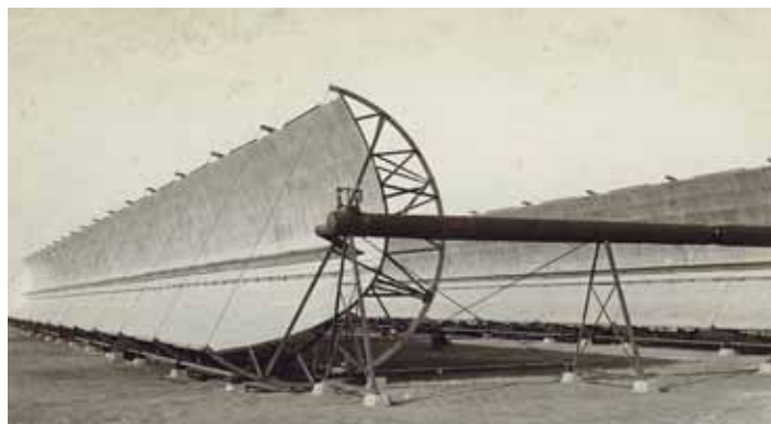
Abbildung 60: Sonnenkraftwerk an der Biennale in Kairo, 1913 (Quelle: Historical Society of Tacony, USA).
