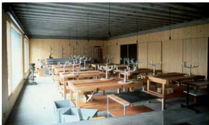
Abbildung 38: Das Schulhaus Vella hat eine Betondecke mit 20 cm breiten und 20 cm hohen Rippen, die im Vergleich zu einer üblichen Decke die doppelte Absorptions- und Speicherwirkung erreicht. Mit den lichtumlenkenden Innenstoren kann das Angebot zur Speicherung noch erhöht werden.
