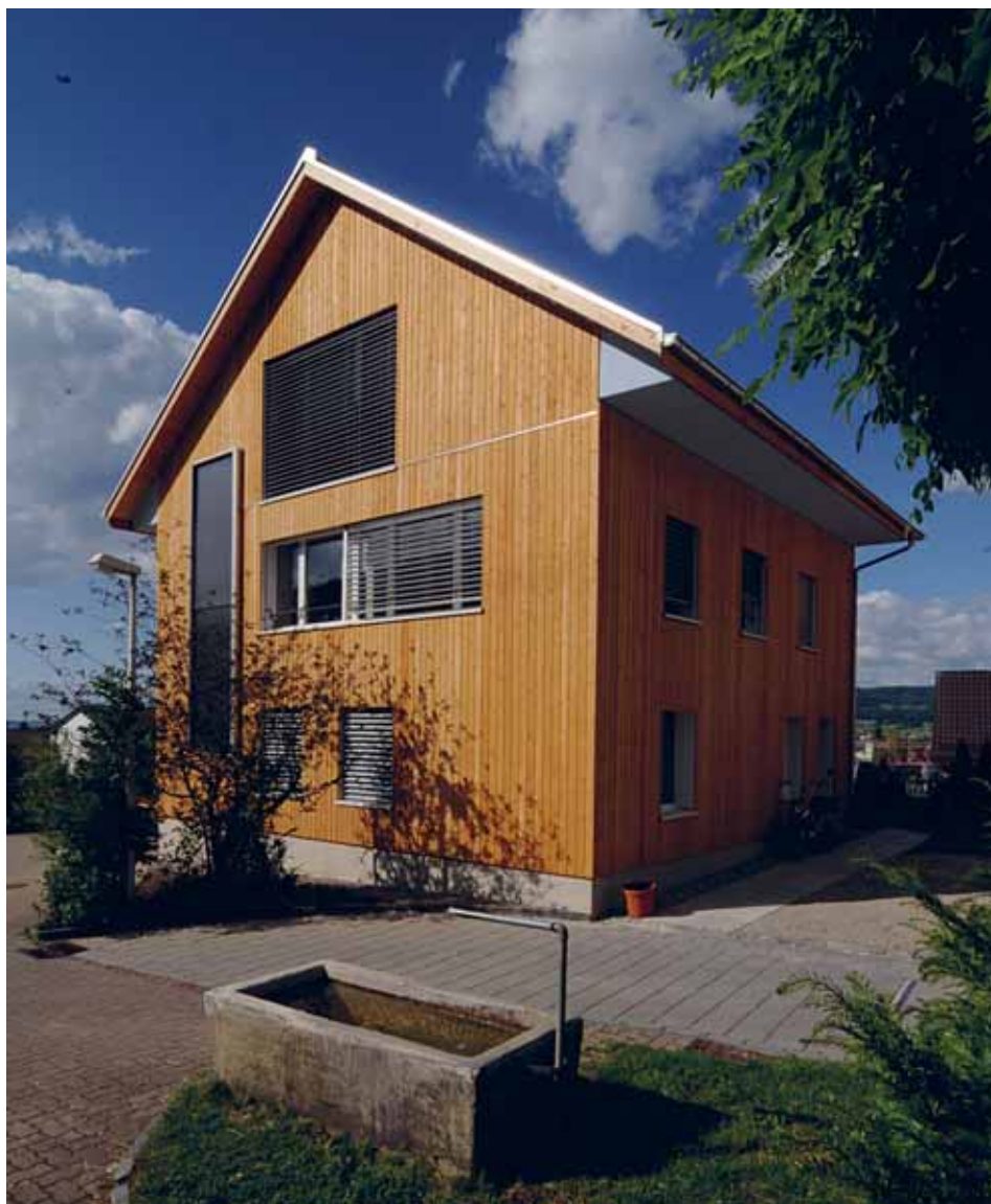
Abbildung 91: Haus Bünter nach der Sanierung – grosse Fenster nach Süden, Fassadenintegrierte Warmwasserkollektoren und Stromproduktion auf dem 60m 2 grossen Dach. Zusammen mit dem Dorfbrunnen bleibt so ein Stück Identität langfristig erhalten.
