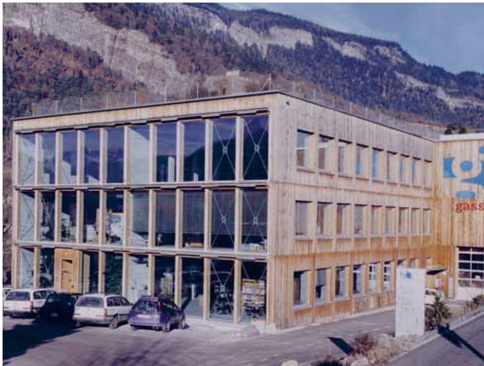
Abbildung 13: Der Verwaltungsbau Gasser in Chur der ARGE Domenig-Rüedi, Chur, zeigt eine weitestgehend unverschattete Südverglasung ohne Vor- und Rücksprünge.
