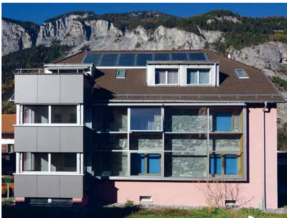
Abbildung 53: Mehrfamilienhaus Scheiwiller in Fels- berg: Der Altbau mit der vorgehäng- ten Überglasung.
