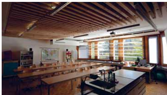
Abbildung 37: Die Stadt Chur realisierte im Jahr 2013 ein Musterschulzimmer, das durch solare Direktgewinnoptimierung und Abwärmenutzung von Schülern 45 % des Wärmebedarfs einspart. Gut sichtbar ist die zusätzliche Speichermasse mit Föhrebälkchen, Lichtumlenkung, Solarglas, Lüftungsgerät und Storensteuerung.
