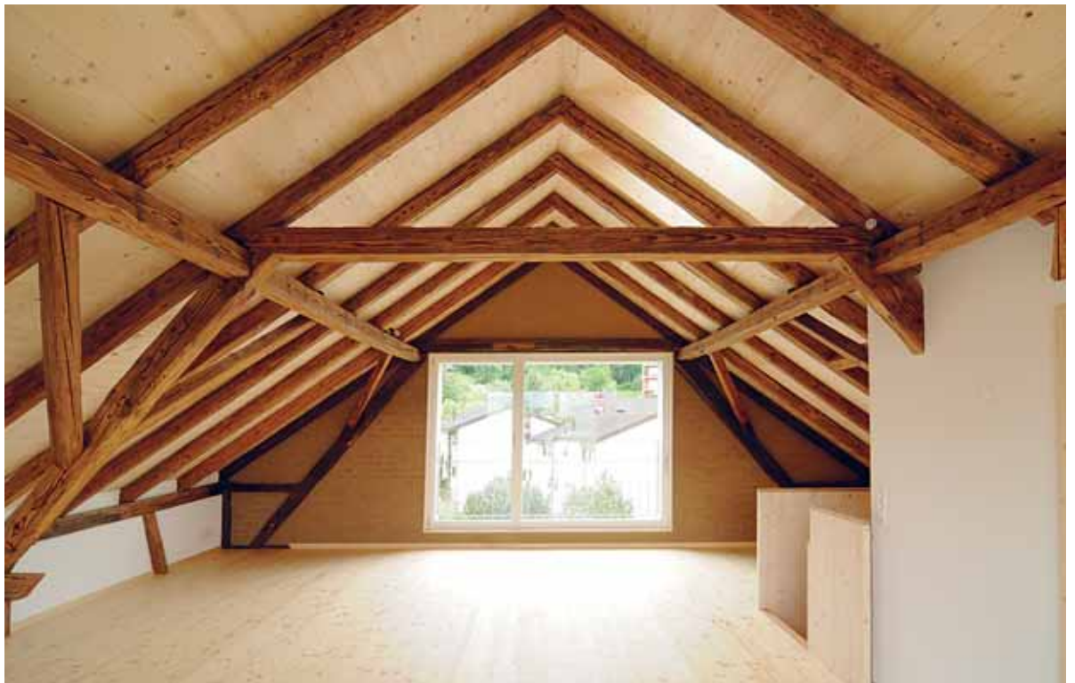
Abbildung 92: 250-jähriger Dachstuhl in neuem Kleid: Balkenlage bestehend gebürstet, Dachdämmung aufgesetzt inklusive neuer Dachstatik, Fassadenbereich mit ungebrannten Lehmsteinen ausgefacht.
