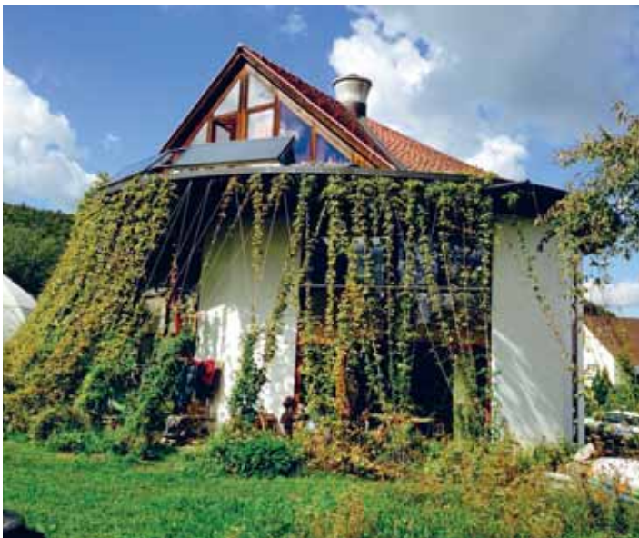
Abbildung 76: Fassadenbegrünung an einem Ein- familienhaus in St. Pantaleon (Bild: Anton Küchler).
