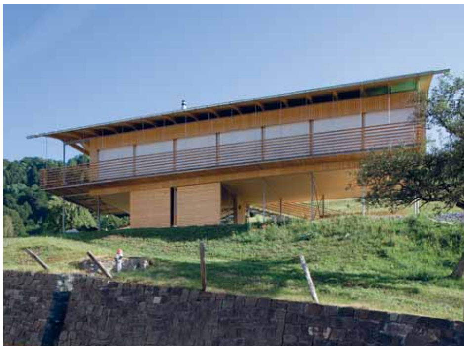
Abbildung 15 (rechts): Beim Haus Flüeler in Luzein von Architeam 4, Basel, ermöglicht die unbehinderte, grosszügige Südöff- nung ein beinahe Nullheizenergie- Konzept – trotz un- günstigem Volu- men-Oberflächen- Quotienten (Bild: Tom Kawara).
