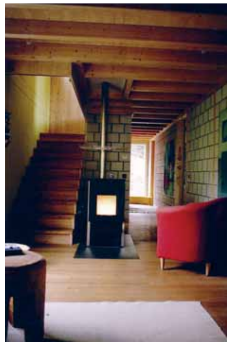
Abbildung 70: Die Holzschürze beim Treppenloch und die raumhohen Zimmertüren garantieren eine gute Wärmeverteilung durch die Warmluft des Aufstellpelletofens.
