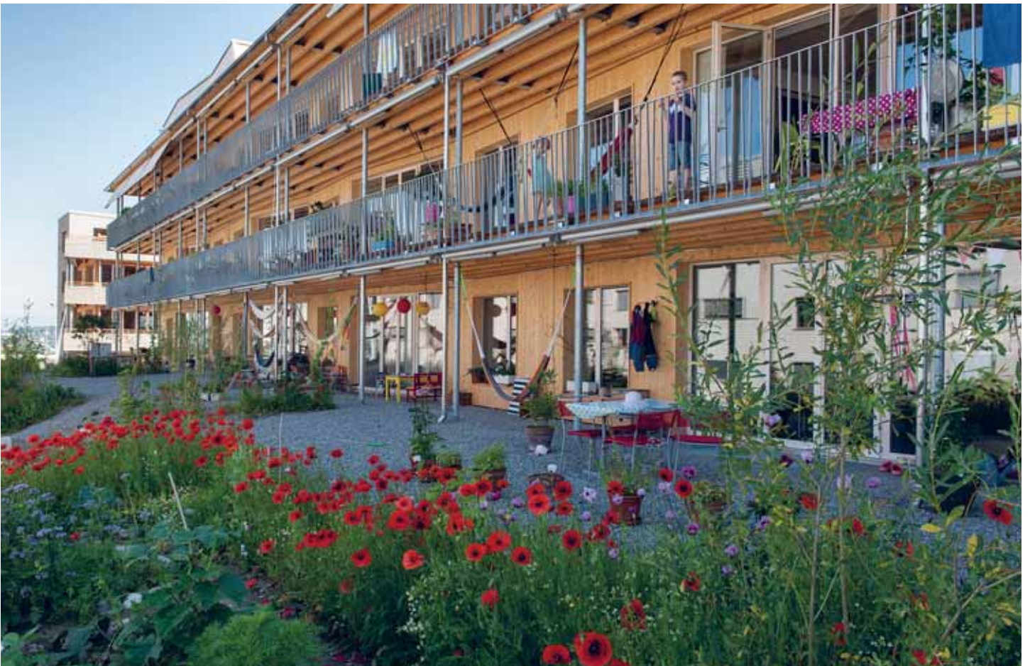
Abbildung 145: Das Bild der Westfas- sade der Siedlung Oberfeld zeigt ein- drücklich die Holz- konstruktion und die durchgehend offenen Balkone (Bild: Christine Blaser).
