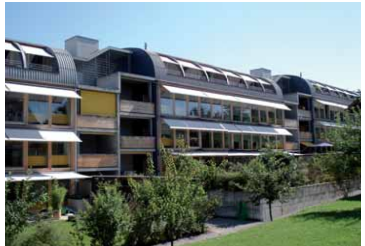
Abbildung 19: Die im Winter abgeschalteten Knickarmstoren als Sommerschattung am Mehrfamilienhaus Terra Nova in Stäfa von Rüedi, Chur.
