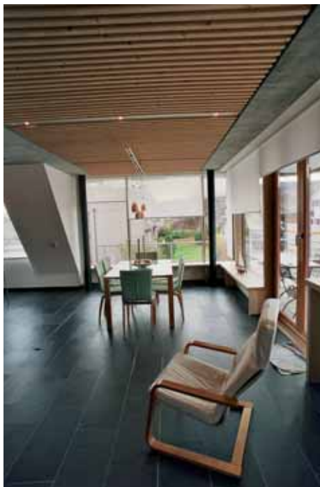
Abbildung 46: Ideal belichtet über zwei Seiten mit Sonnenschutz aussen und Blendschutz innen, unbeheizter dunkler Steinboden für die Speicherung, eingegossene Holzrippendecke für optimierte Wärmeaufnahme und Akustik, Beleuchtung und wenig Armierungsstahl. Punktstützen für eine langfristig flexible Raumnutzung.
