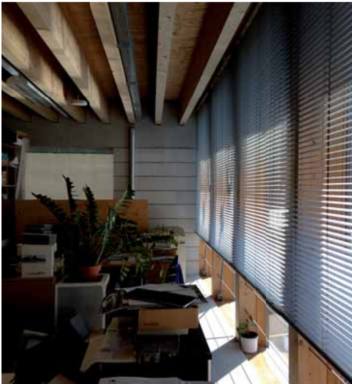
Abbildung 20: Innerer Blendschutz im Bürohaus Gasser. Dieser wird durch das Leitsystem bei entsprechender Sonnenstrahlung und Innentemperatur automatisch heruntergefahren. Da sich der Sonnenstand laufend ändert, muss die Endstellung der polierten Lamellen monatlich programmiert werden. Die Umlenklamellen dürfen dabei nicht bis zum Boden reichen, da sonst Sitzende schneller geblendet werden. Ein Kriterium für die Höhe ist, dass keine Sonne auf die Tischplatte fällt. Achtung: Ist der Boden zu hell, kommt es zu Blendeffekten. Ein dunkler Boden kann gleichzeitig als Primärsolarspeicher genutzt werden. Auf diesem Bild sieht man das durch die polierten Lamellen an die Decke umgelenkte Licht. Die Tageslichtnutzung verbessert sich deutlich und die Decke wird zum Primärspeicher.
