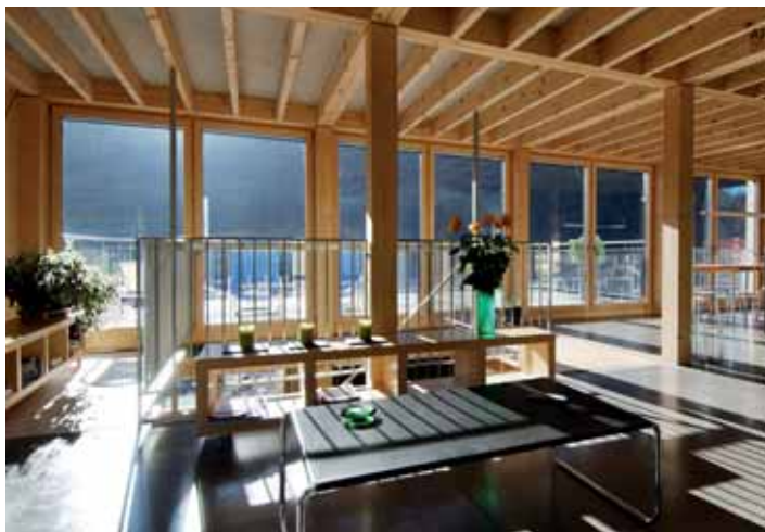
Abbildung 39: Im Modulbausystem Living-Box von Architeam 4 und Ruwa Holzbau werden die Boden-Decken-Module zur Absorption und Speicherung eingesetzt. Die auf dem Rütteltisch als Holzbeton-Verbund produzierten Teile kommen fertig auf die Baustelle. Beton und Holz speichern die Sonnenwärme (Bild: Tom Kawara).
