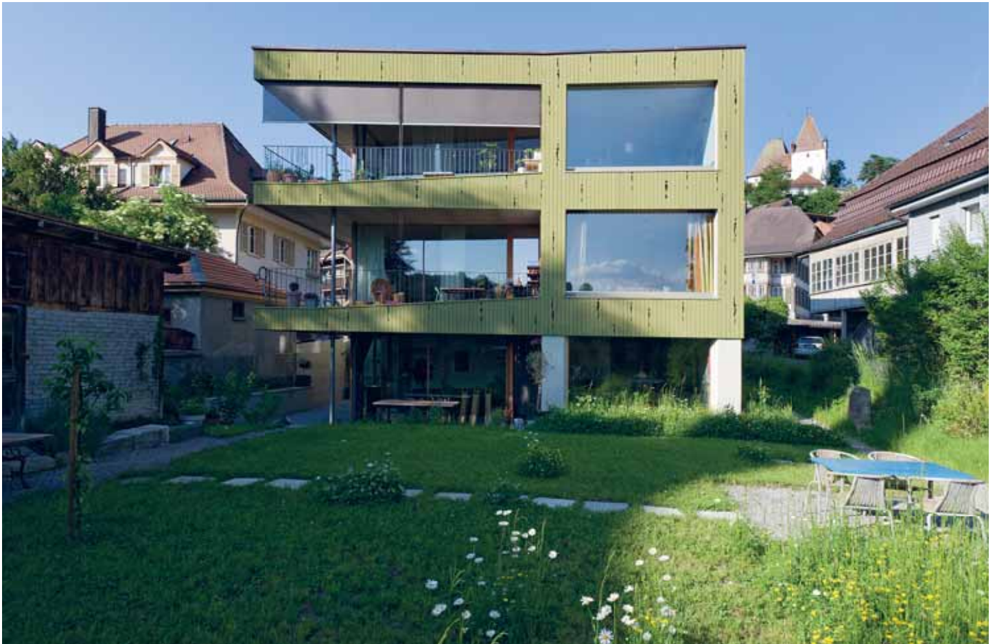
Abbildung 126: Auf dem Sockelgeschoss aus Recyclingbeton wurde eine Holzständerkonstruktion errichtet (Bild: Christine Blaser).
