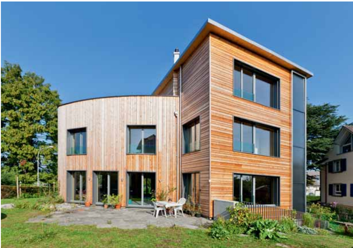
Abbildung 96: Direktgewinn über drei Geschosse mit grosszügigen Fenstern. Fassadenintegrierte Warmwasseranlage.
