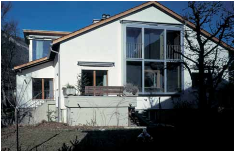
Abbildung 56 (rechts): Die südlich orientierte Giebelwand mit den 6 Fensterelementen, wovon 4 dem Luftkollektor dienen (oben das mittlere Element, unten alle 3 Elemente).
