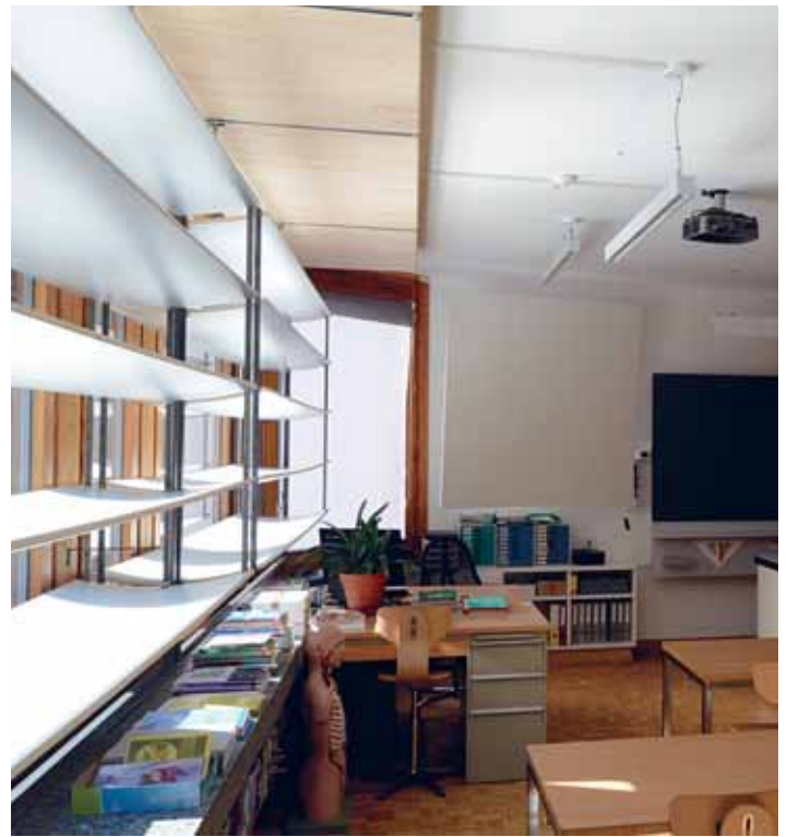
Abbildung 21: Die breiten, gebogenen und von Hand schwenkbaren Lichtumlenklamellen wurden mit einem Schlosser und einem Schreiner als Prototyp produziert. Mit diesen Lamellen kann auch verdunkelt werden. Wichtig dabei ist, dass die Aussenfläche mindestens eine mittlere Dunkelheit aufweist. So wird die Strahlung nicht nach aussen reflektiert. Die Lamellen absorbieren das Licht und werden warm. Hinter den Lamellen sowie oben und unten muss genügend Raum bleiben, dass die erwärmte Luft zirkulieren kann. Angewendet in einem Musterschulzimmer, das auf Seite 27 und ab Seite 106 ausführlich dokumentiert ist.
