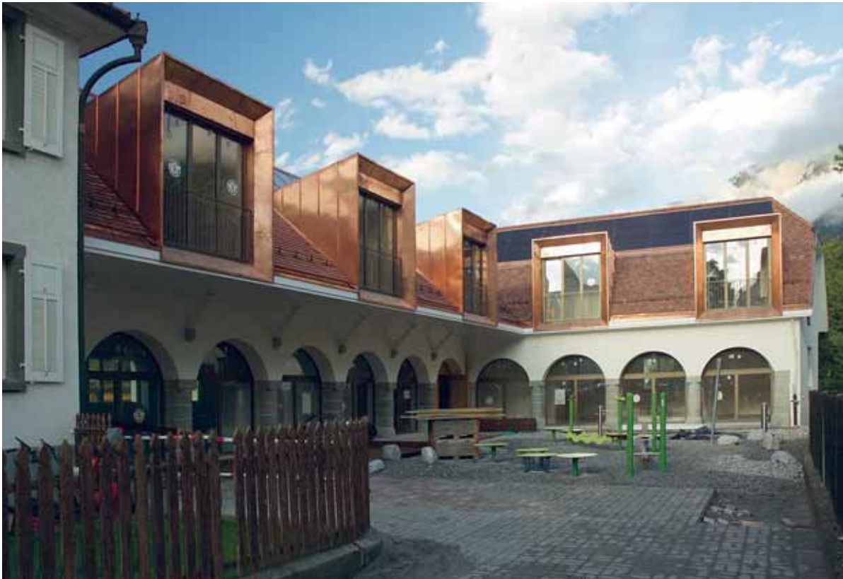
Abbildung 150: Neue, grosse Lukarnen bringen Licht und Wärme in die Wohnräume im Dachgeschoss.
