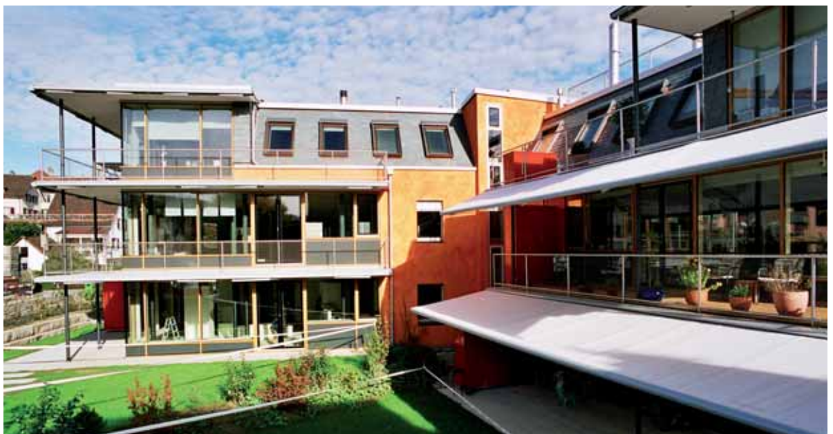
Abbildung 138: Während die Südfassade nur schmale Balkone aufweist, sind die tiefen Balkone gegen Westen ausgerichtet. Grosse, elektrisch gesteuerte Sonnenstoren prägen die Gestaltung in den Sommermonaten.
