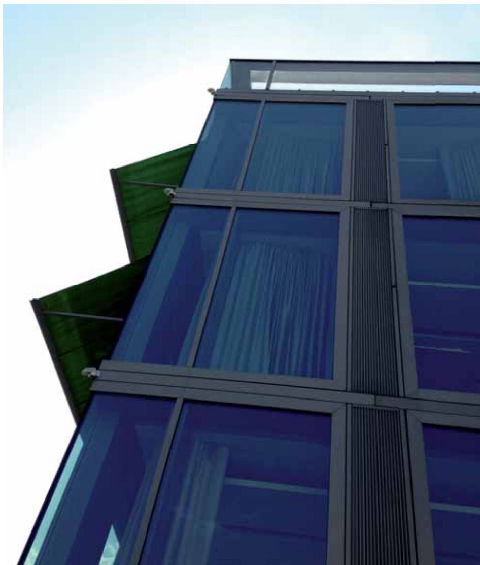
Abbildung 27: Die wettersicheren, automatisierten Querlüftungsklappen des ÖKK-Verwaltungsgebäudes in Landquart von Bearth und Deplazes, Chur. Hier sieht man die Beschattungslösung und den inneren Blendschutz mittels Vorhängen. Als problematisch haben sich hier die nicht gelöste Übereck-Verschattung und die aus Kostengründen gewählte 2-fach-Verglasung erwiesen.
