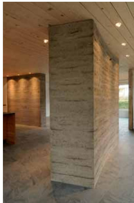
Abbildung 48: Stampflehm, statisch tragend eingesetzt, Gewicht 14 t, vorgefertigt in zwei Elementen, Dicke 50 cm, als solarer Wärmespeicher, feuchteausgleichend, geruchsneutralisierend, natürlich gestaltete Trennwand, problemlos reparierbar, rückbaubar mit Wasser zur Wiederverwendung.
