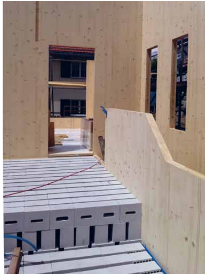
Abbildung 103 (unten rechts): 17 Tonnen Kalksandsteine in den Decken speichern Wärme der Sonne.
