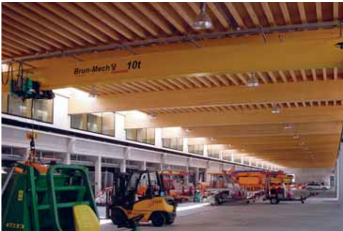
Abbildung 171: Sichtbezug zwischen Administration und Technik durch erhöhte Lage der Büros.
