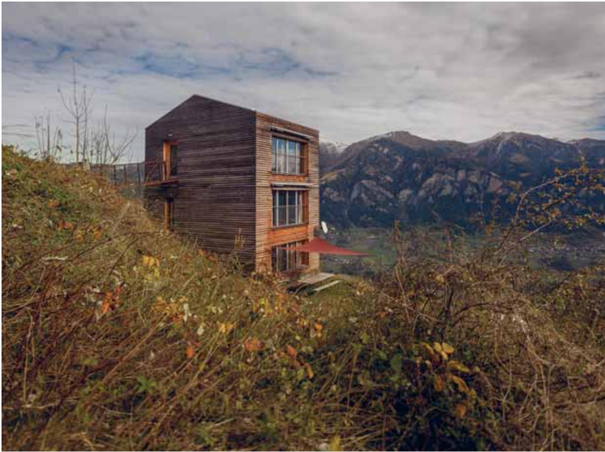
Abbildung 82: Sicht auf die Südfassade mit äusseren Knickarmstoren und Segel für den Sommerbetrieb (Bild: Patrick Kälin).
