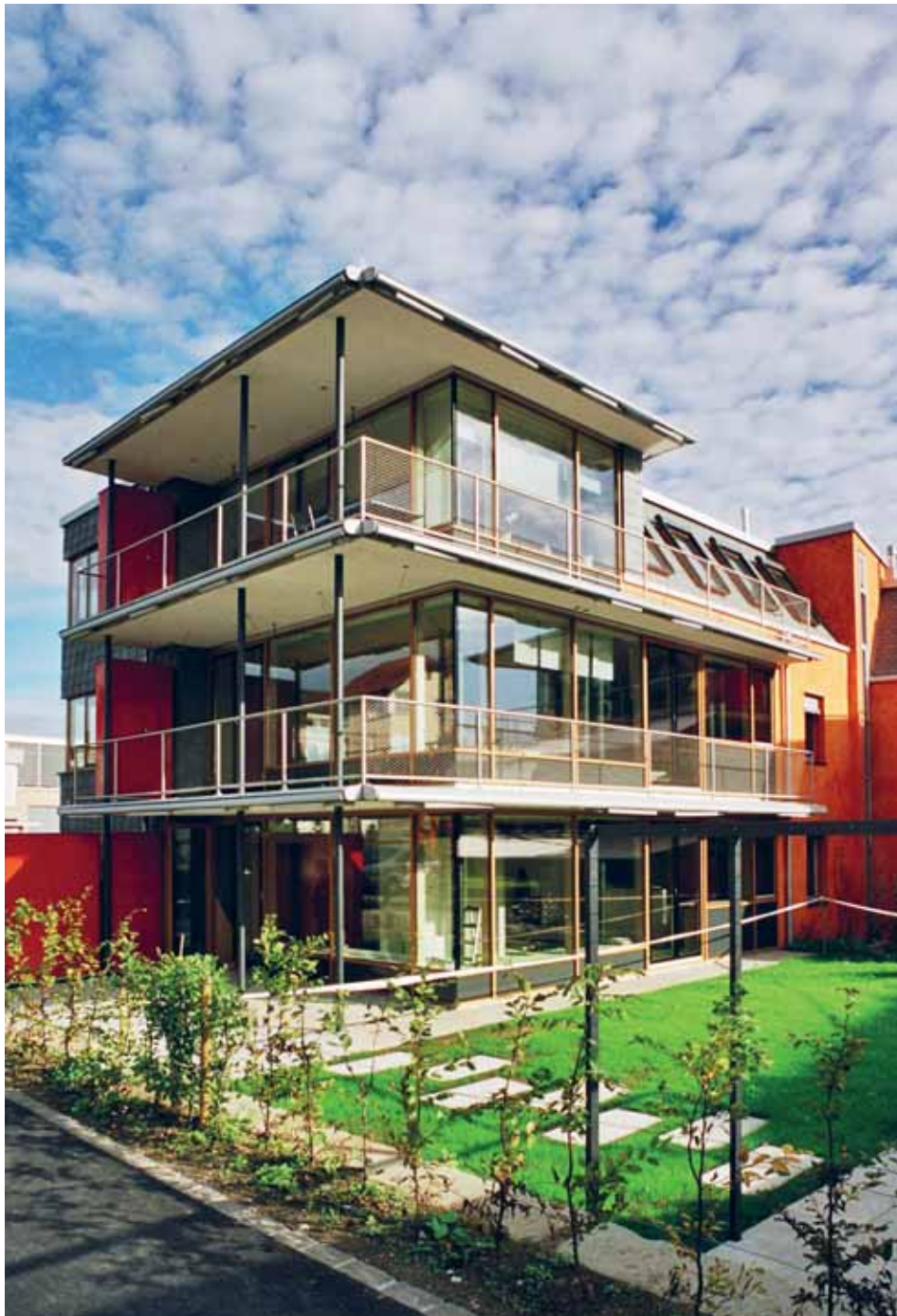
Abbildung 4: Mehrfamilienhaus in Thalwil (Architektur Oikos & Partner, Energiekonzept Andrea Rüedi). Solarer Direktgewinn im Winter über grosse Südverglasung mit Verschattung im Sommer; kontrollierte Lüftung mit Abluft-Wärmepumpe zur Produktion von Warmwasser, Kleinöfen pro Wohnung für die Übergangsphase zum selber Heizen und zentrale Pelletheizung als ergänzende Wärmequelle bei Unterversorgung von Heizung oder Warmwasser.
