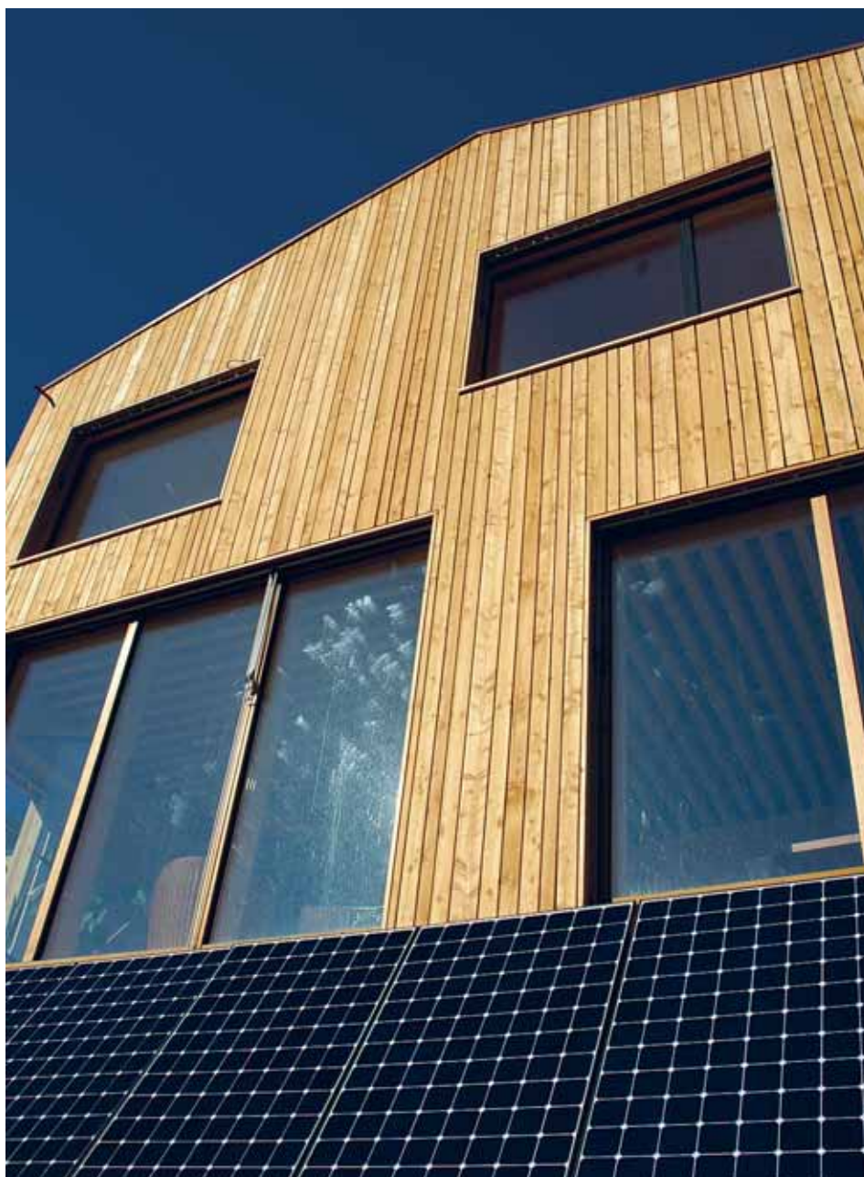
Abbildung 100: An der Südfassade in Holzbauweise decken 27 m 2 grosse Fensterflächen 69% des Wärmebedarfs und eine 3,8-kWp-Photovoltaikanlage den Strombedarf.
