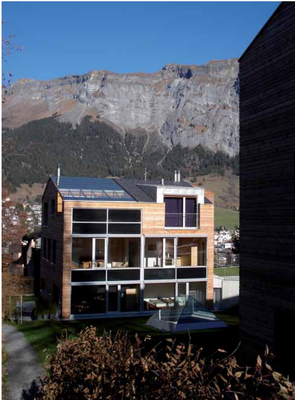
Abbildung 58: Eines der beiden Plusenergie-Dreifamilienhäuser Riedi in Flims von Rüedi, Chur, mit in die Südfassade integrierten Wasserkollektoren, kombiniert mit Direktgewinn und Photovoltaik auf dem Dach.
