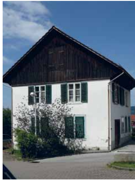
Abbildung 90: Bestehendes Gebäude mit Werkstatt im Erdgeschoss, Wohnung im Obergeschoss und kaltem Estrich vor der Sanierung.
