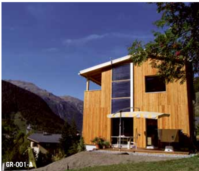
Bereits zertifiziert: Minergie-A Einfamilienhaus in Zernez.
