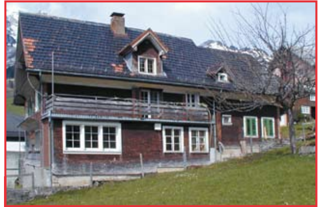
Das Gebäude vor der Sanierung. Der Anbau mit der Terrasse stammt aus dem Jahre 1900.
