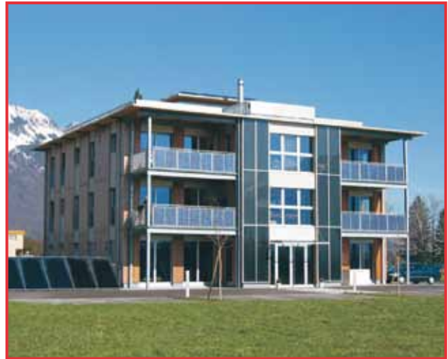
Neubau Mehrfamilien- und Bürohaus, Gams, SG-115
