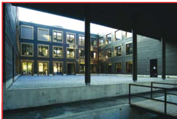
Das quadratische Gebäude hat einen grosszügigen Innenhof. Die Brücke rechts führt über den Suhrelauf zu den Ateliers.
