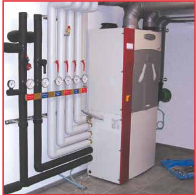
Eine für alles: Die Kompaktenergiezentrale Comfobox im Technikraum vereint effiziente Raumheizung und -kühlung, Warmwasserbereitung und Komfortlüftung.
