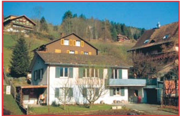
Das Gebäude mit Baujahr 1961 vor der Erneuerung.
