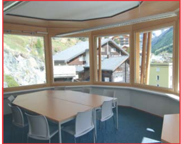
Grosse Fenster (im Lehrzimmer) sind der passiven Nutzung von Sonnenenergie förderlich.
