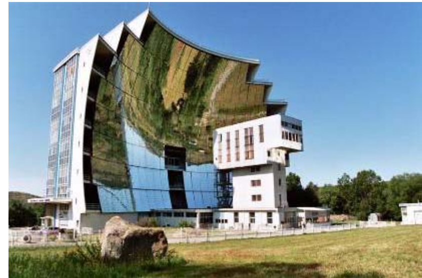
1100 kW, 4000 °C Solarschmelzofen Odeillo, Spanien
