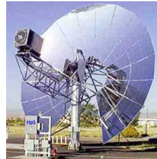
10 kW Dish-Stirling-Anlage in Spanien
