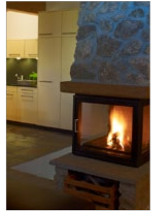
Bei Holzöfen: Lüftungstechnik darf keinen Unterdruck erzeugen, der die Feuerung stören kann.
