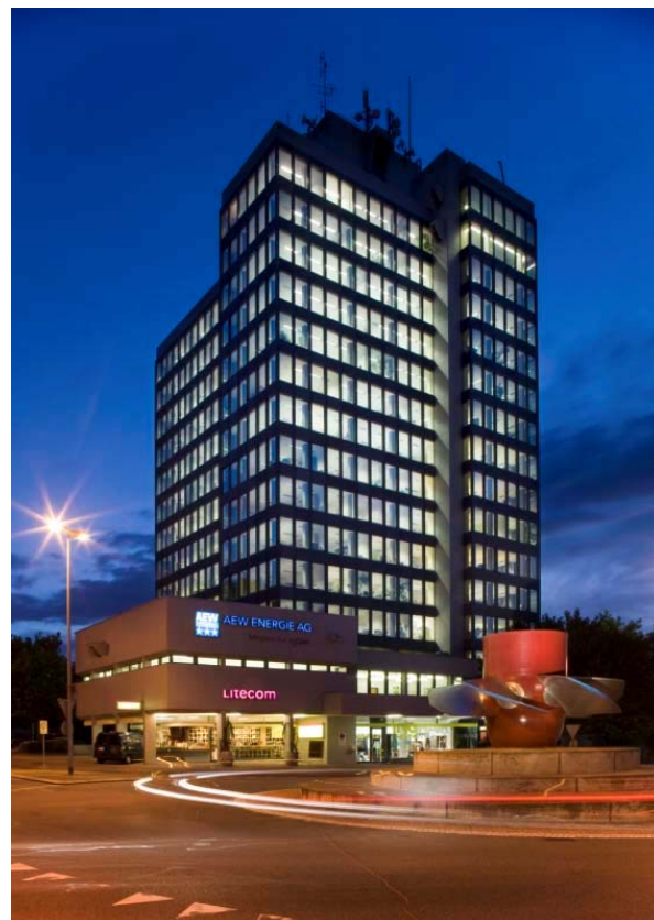
Seit vier Jahrzehnten ein Wahrzeichen von Aarau: Das AEW-Hochhaus gefiel sich schon immer als Vorreiter in Design und Technik.
