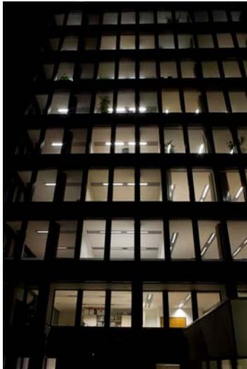
Passgenau und konsequent: In sämtlichen Büros wurden Strom sparende Leuchten aus dem Haus TRILUX installiert.
