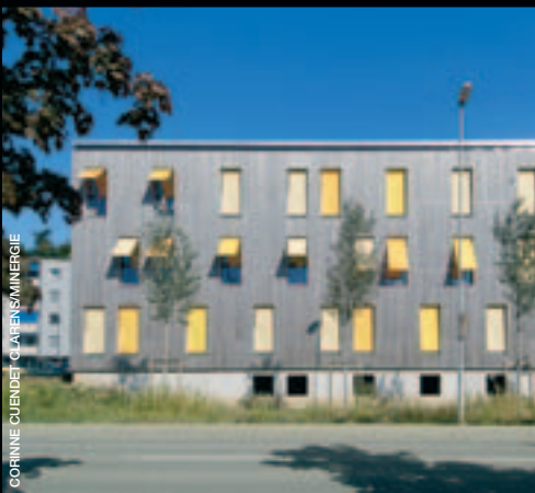
BUREAUX À FRIBOURG (Suisse) Conrad Lutz, architecte.
