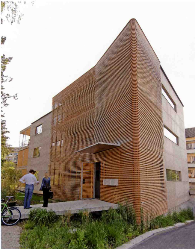
Ein Mehrfamilienhaus in Liebefeld... Maison à plusieurs familles à Liebefeld...
