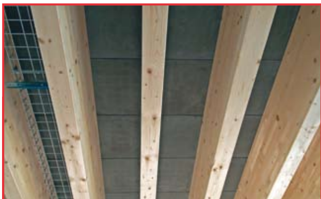
Des dallettes de jardin, qui entrent dans la composition des planchers intermédiaires, contribuent à améliorer l'inertie thermique du bâtiment.
