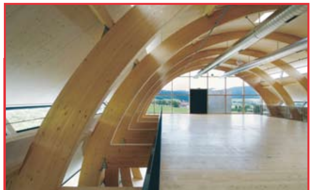
Les 18 arches constituant l'ossature du Mycorama
