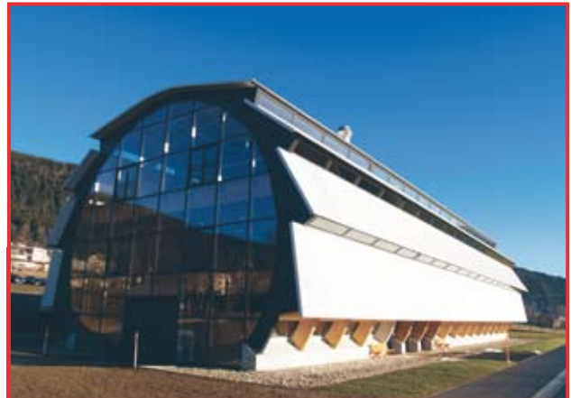
Un socle en béton et une fondation filante sur laquelle reposent les arches
