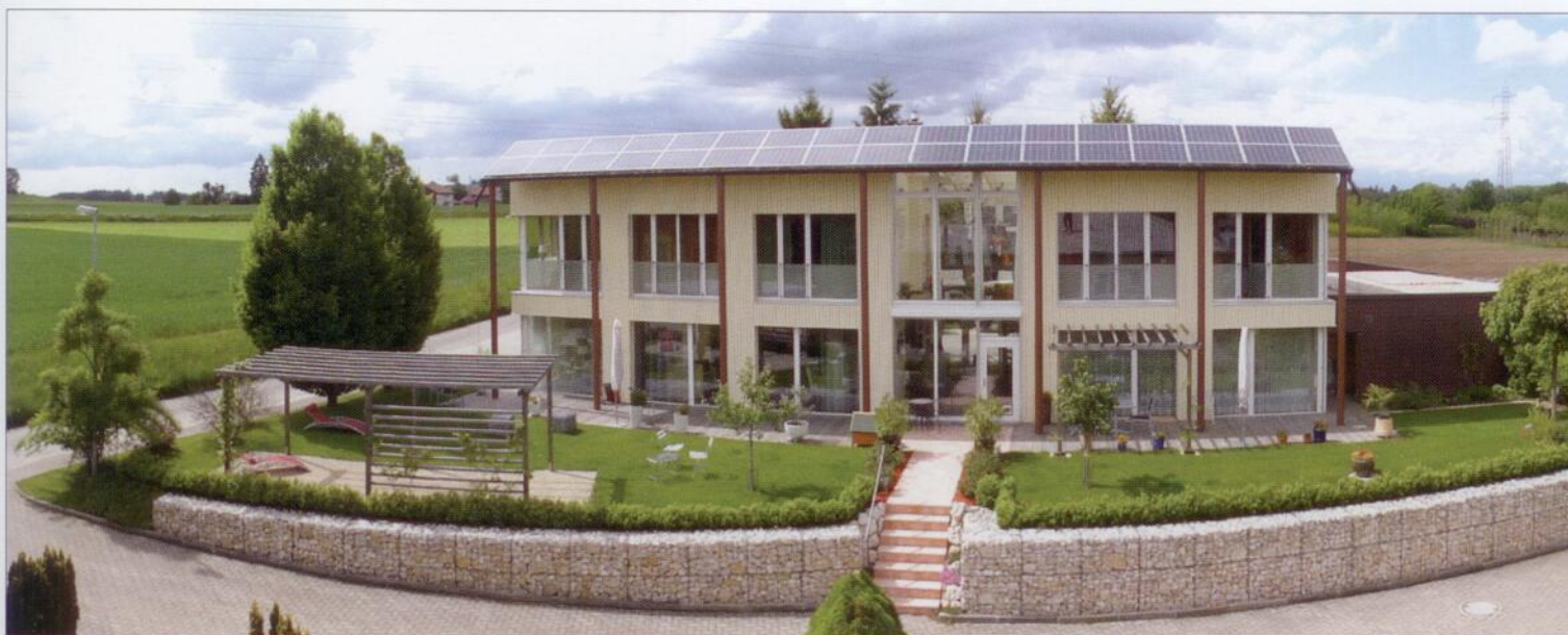
Jetschwil/FR, réf FR-001-A: premier label Minergie-A-Eco du canton de Fribourg. Construction de 2 appartements. Architecture: Lutz Architectes Sàrl.
