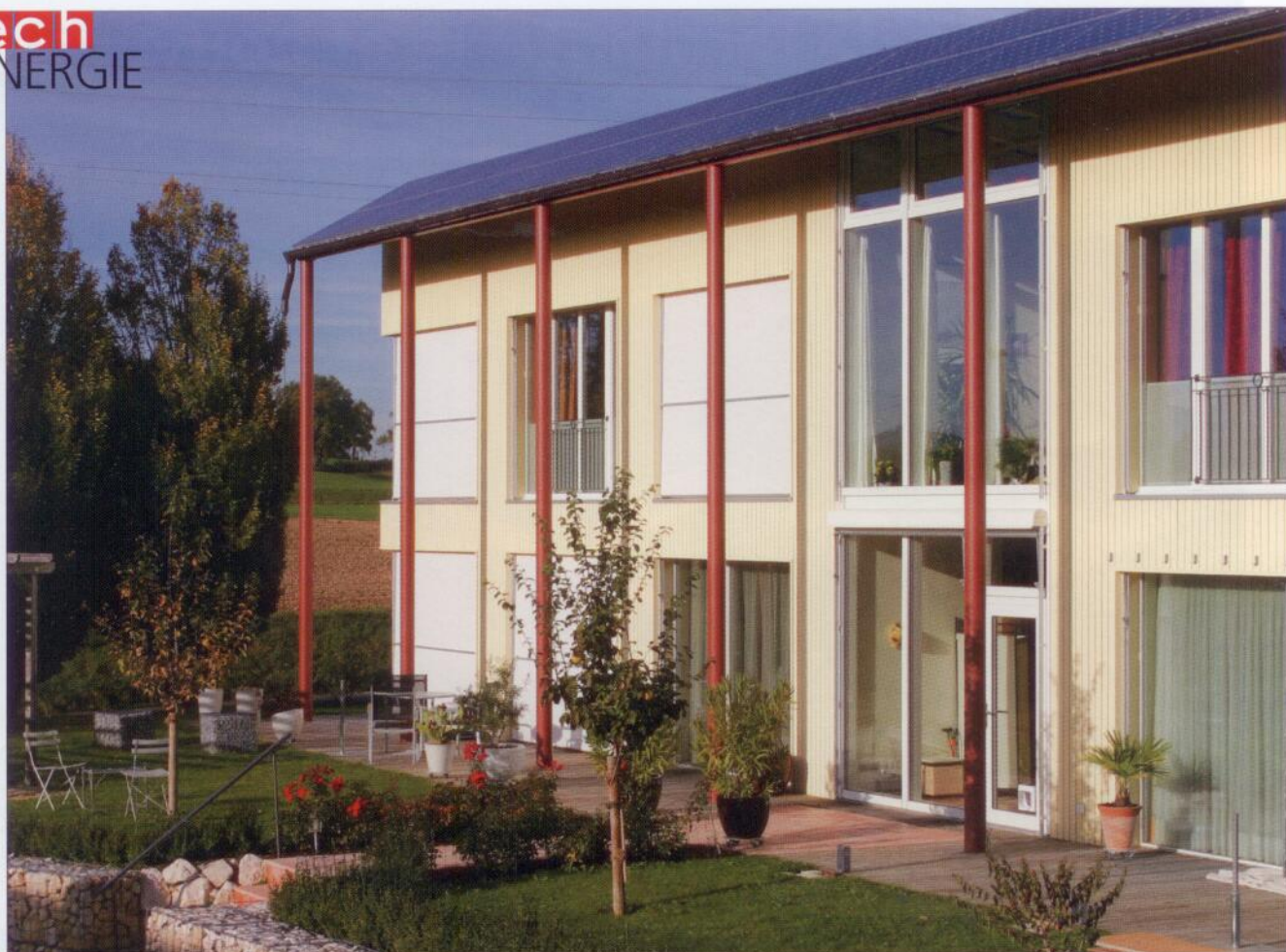
Jetschwil/FR réf FR-001-A: 100% chauffage au bois, 63% solaire thermique, 37% chauffage au bois.
