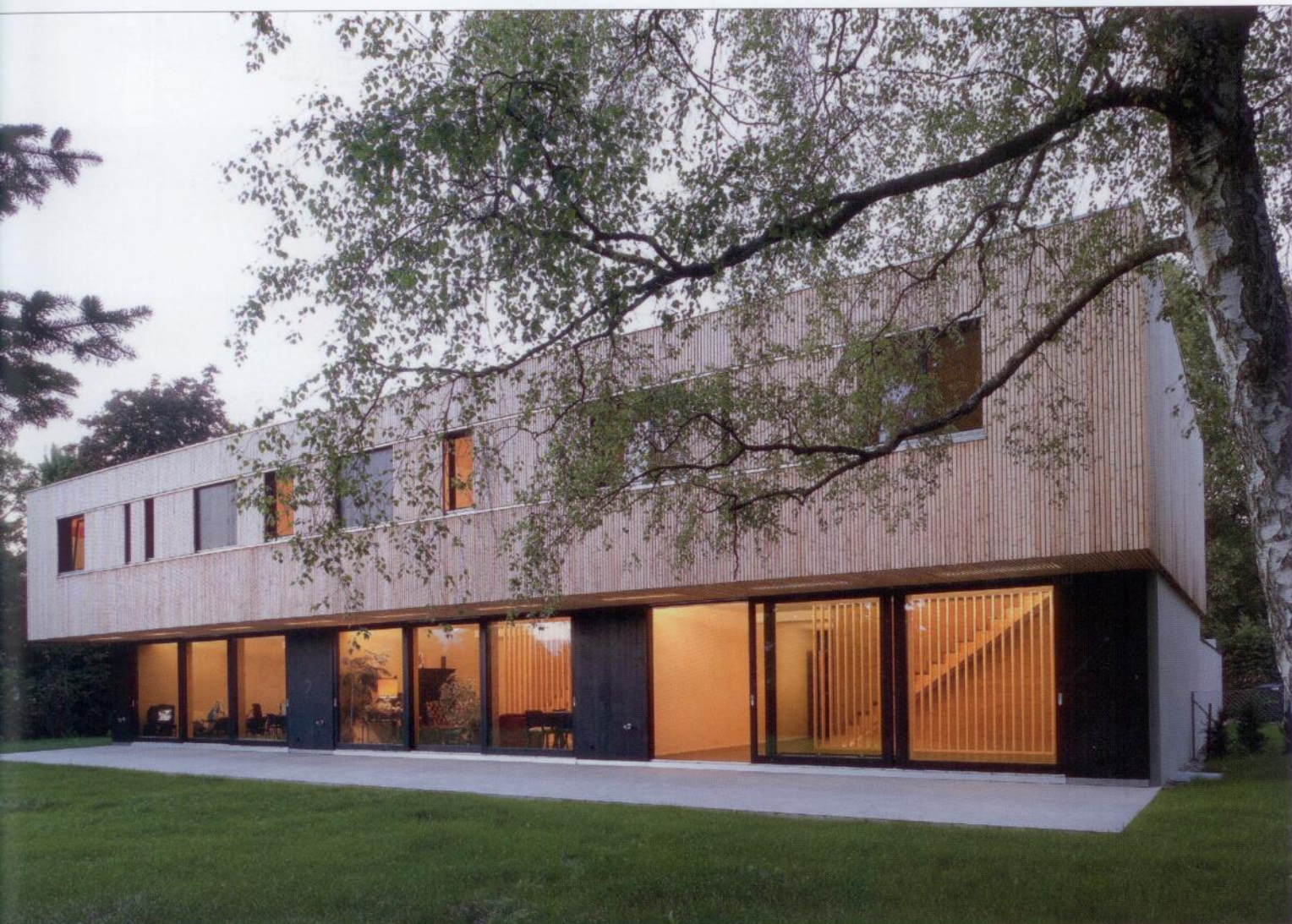
Trois logements contigus de 170 m 2 habitables chacun qui répondent au standard Minergie-Eco. Le Grand-Saconnex, Genève, Architectes Christian von Düring & Monica Suarez PHOTO THOMAS JANISCHER ET VON DÜRING
