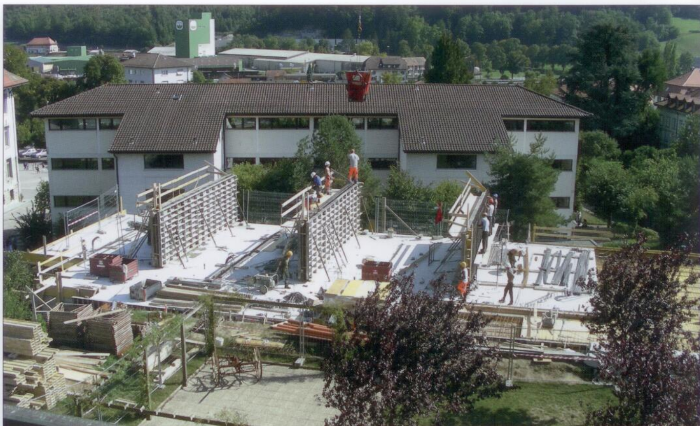
Montage des éléments porteurs.
