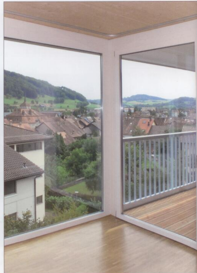
Les murs sont peints à la chaux. Les plafonds se constituent d'une structure trois-plis apparente et les sols sont revêtus d'un parquet en chêne.
