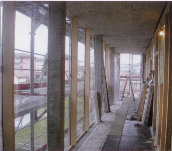
Charpente extérieure: des panneaux fermacell habillés de laine de roche et d'un crépi minéral compact périphérique (système Marmoran) envelopperont la structure bois.
