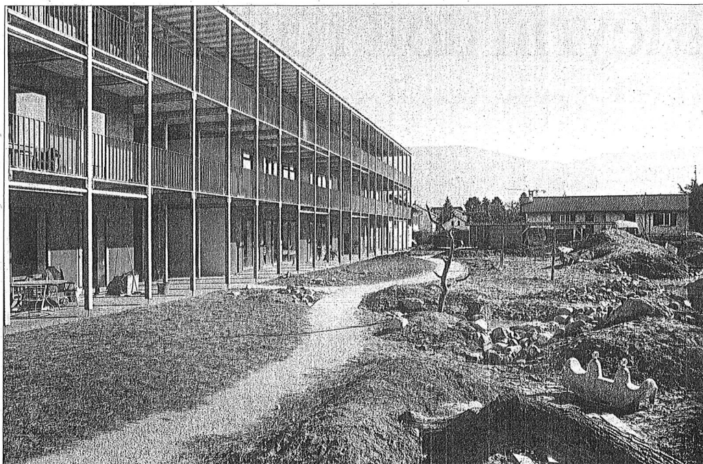
Avenue du Millénaire. L'immeuble de bois se dresse devant le futur jardin. La communication entre les appartements se fait grâce à un balcon sans séparation, véritable espace de vie chaleureux et convivial. (PHOTOS DE PASCAL FRAUTSCHI)
