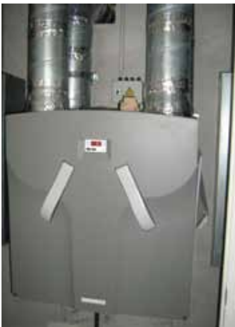
Esempio di apparecchio per l'aerazione controllata in un'abitazione monofamiliare.
