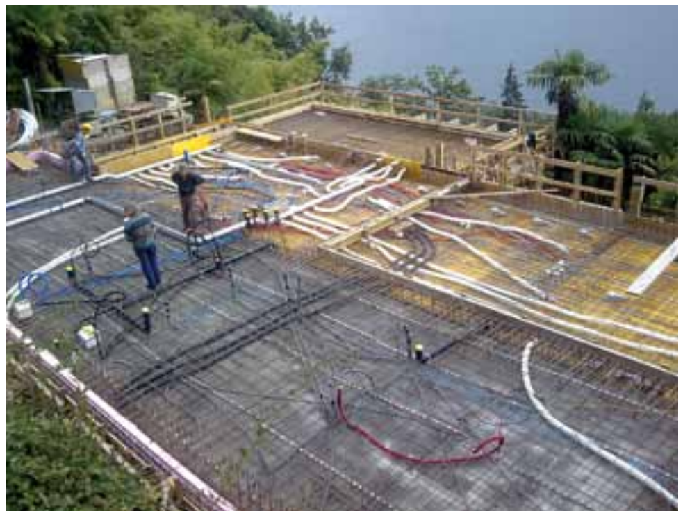
Posa dei tubi dell'aerazione controllata nella soletta (tubi bianchi).
