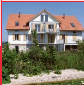
Edificio plurifamiliare ammodernato, Steinhausen, ZG-047
