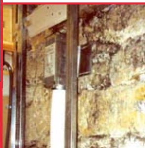
Distribuzione e scatola per la bocchetta nell'isolamento termico interno
