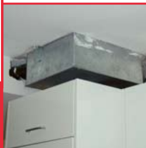
Scatola di distribuzione installata nei vani sopra gli armadietti della cucina
