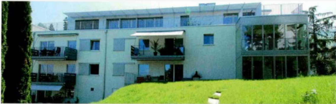
Minergie-P-Sanierung ZG-011_P: Aus einer «Energieschleuder» aus dem Jahre 1946 wurde durch Anbau, Aufstockung und Passivhaustechnik ein vorbildliches Minergie-P-Gebäude. Vakuumkollektoren auf dem Dach, Erdsondenwärmepumpe, kontrollierte Lüftung sowie PV-Aufdachanlage sorgen CO 2 -frei für Wärme, frische Luft und Elektrizität.
