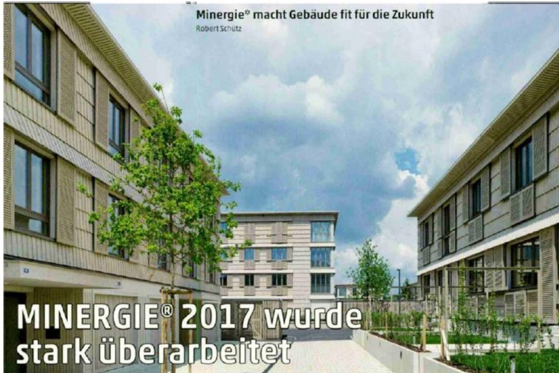
■ Minergie-A Eco Gebäude (AG-001-075-A-Eco) am Kirschenweg 1 in Mellingen. (Bilder: zVg)
