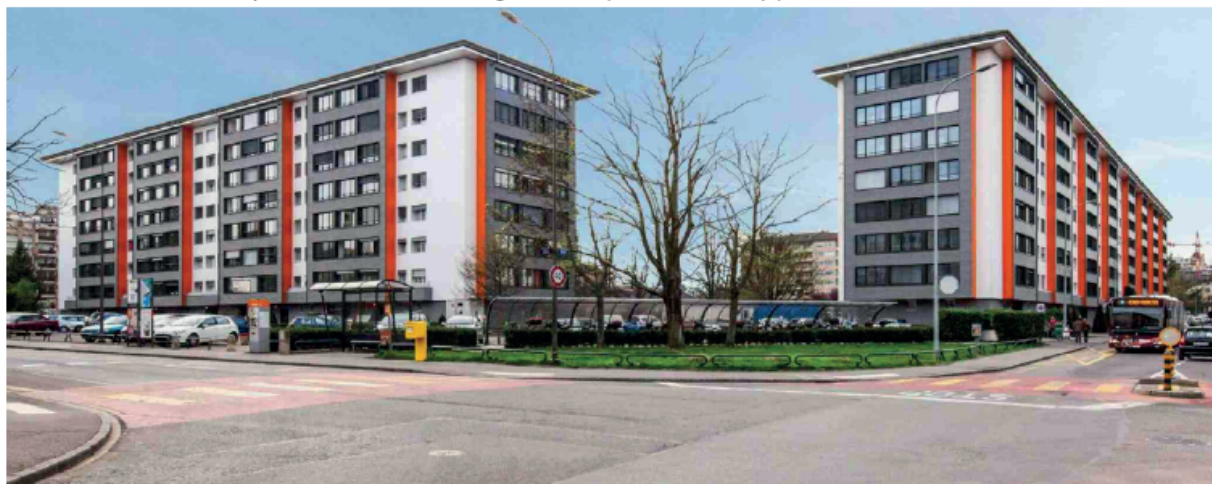
Le projet-pilote de la société coopérative La Cigale, à Genève, est la plus grande rénovation Minergie-P en Suisse. Elle a divisé par cinq les besoins énergétiques totaux des deux bâtiments des années 1950. Photo: Prix Solaire Suisse 2014, Agence Solaire Suisse
