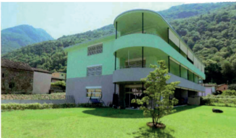
Die Residenza Orbello in Arbedo ist das erste Mehrfamilienhaus im Tessin, das nach dem Minergie-A-Standard erbaut wurde. (Bilder: Elco)
