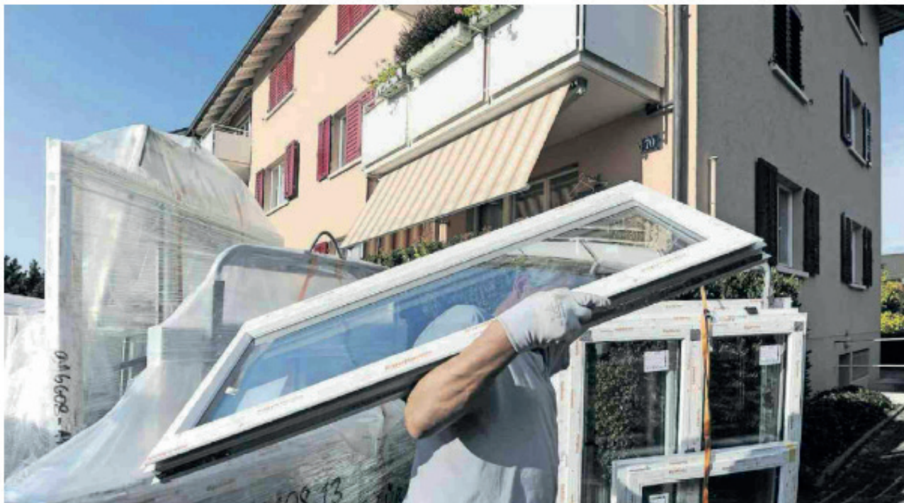
Die Aussenhülle ist bei nicht sanierten Gebäuden oft die Schwachstelle: Ersatz von Fenstern an einem Mehrfamilienhaus in Zürich.
