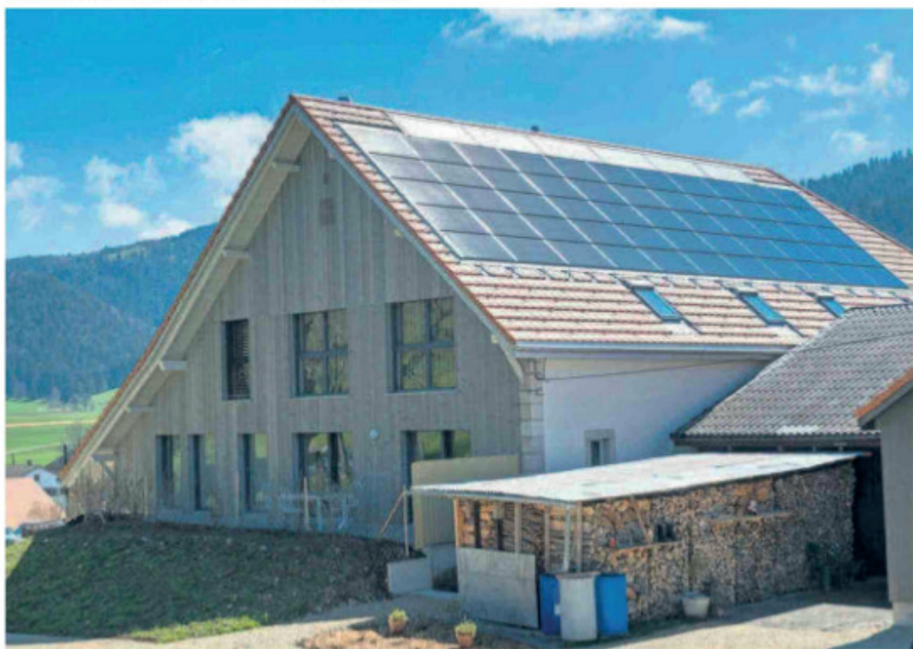
Cette ancienne ferme, construite en 1851, a été entièrement transformée l'an dernier. Dotée de capteurs solaires thermiques et photovoltaïques, elle a obtenu le label Minergie-P. JEAN-PAUL GUINARD
