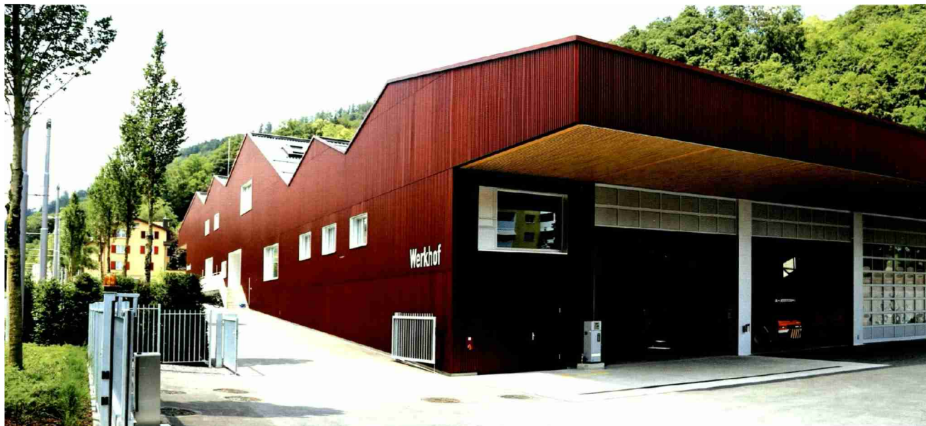
Einer von vielen Werkhöfen mit Minergie-Eco-Energiestandard: Feuerwehr- und Werkhof Eichenspes in Kriens.
