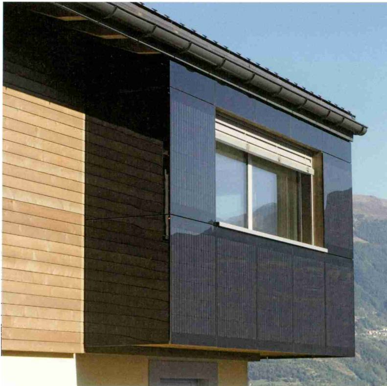
Figur 2: Beispiel einer fassadenintegrierten PV-Anlage
