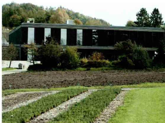
Westansicht Büro- und Laborgebäude
