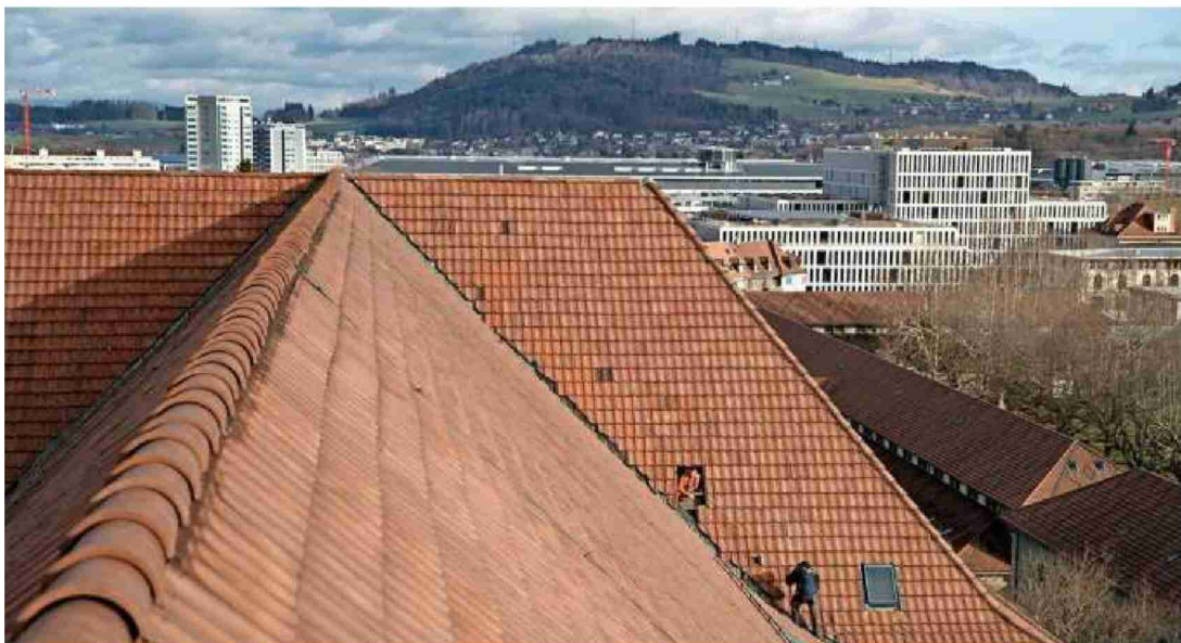
Das Gebäude der Erziehungsdirektion hat viele Fenster und wirkt dadurch leicht. Die Fassade ist geschützt, über die Balkone dringt im Winter aber Kälte nach innen.
