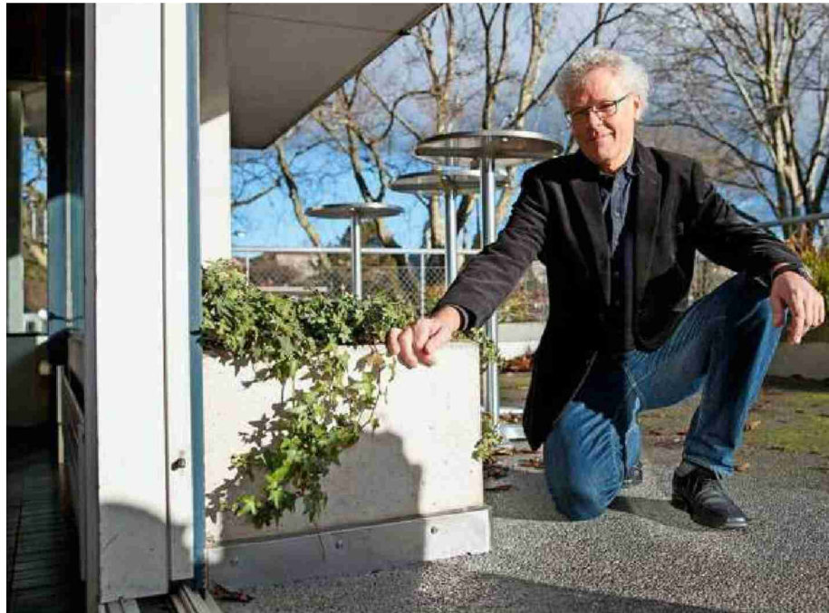
Bruno Rankwiler bei den Blumentrögen des Erziehungsdirektion-Gebäudes. Da die Kisten direkt mit der Wand verbunden sind, dringt durch sie Wärme nach draussen.
