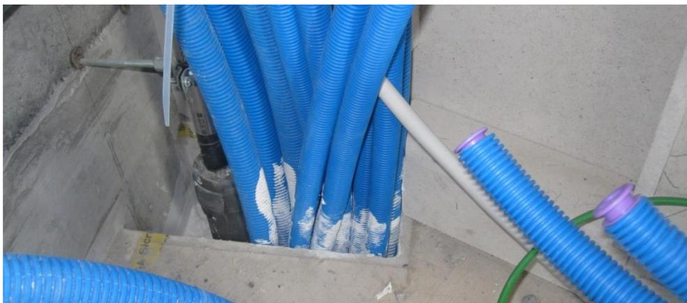
Illustration 7: Inapproprié: installation électrique en faisceau (source: Haute école de Lucerne – Technique et architecture; photo: 30.11.2013)
