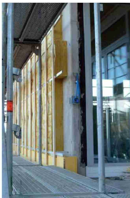
Schnittstellen bei energieeffizienten Gebäuden sind besonders anspruchsvoll.
