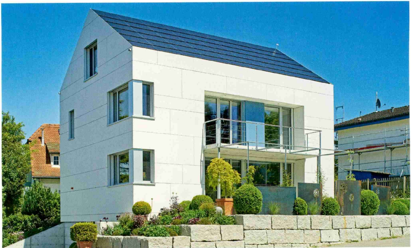
Beispiel eines Einfamilienhauses mit einer Fassadenbekleidung aus Faserzement und Photovoltaik-System «Integral-2».
