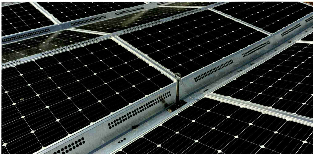
PV-Anlage auf Flachdach, modernes Montagesystem für Ost/West-Ausrichtung. Die Leistungsdichte bei Solarmodulen ist enorm: Bereits können mit 3 Modulen auf weniger als 5 m 2 eine Leistung von 1 kW erzeugt und übers Jahr rund 1000 kWh produziert werden.
