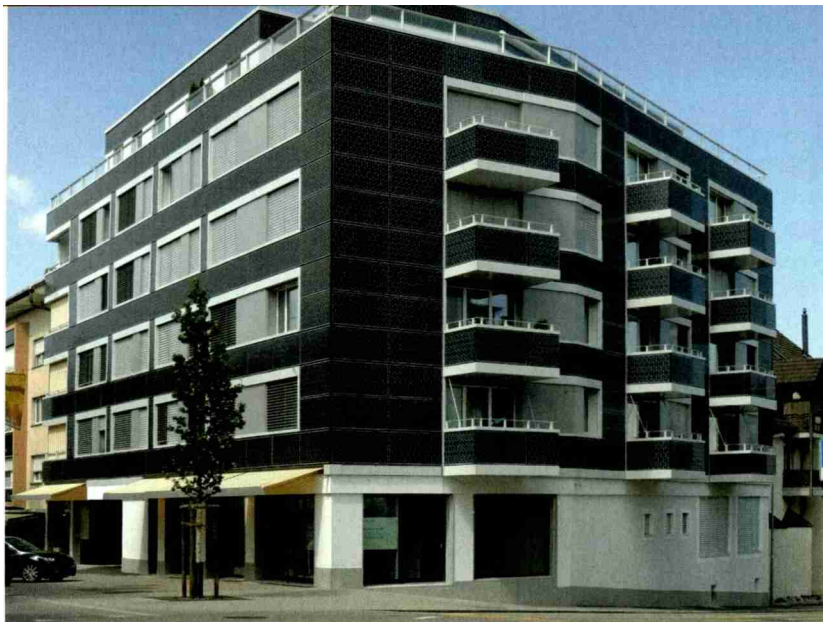
Romanshorn, Mehrfamilienhaus Alleestrasse: Das Gebäude aus den 60er-Jahren wurde so modernisiert, dass es heute in der Jahresbilanz mehr Energie produziert als es für Warmwasser, Heizung, Wohnungslüftung und Haushaltsstrom benötigt. Neben der Energiegewinnung dienen die gebäudeintegrierten Photovoltaik-Module auch als Witterungsschutz.
