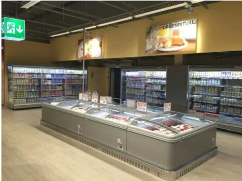
**Mobile, verschiebbare steckerfertige Aktionstruhe**
