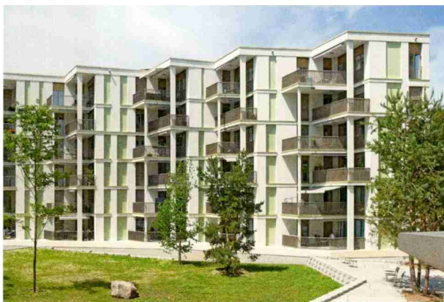
Verspielt: Wohnsiedlung Buchegg, Zürich, mit Minergie-P-Zertifikat; Baujahr 2018; Architektur: Duplex Architekten Zürich.
