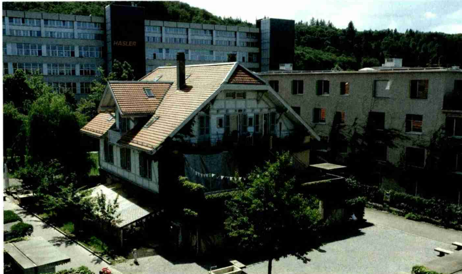
Das nach Minergie-Kriterien sanierte Hofhaus ist gesellschaftlicher Treffpunkt der Siedlung Burgunder und beherbergt u. a. eine Kindertagesstätte.
