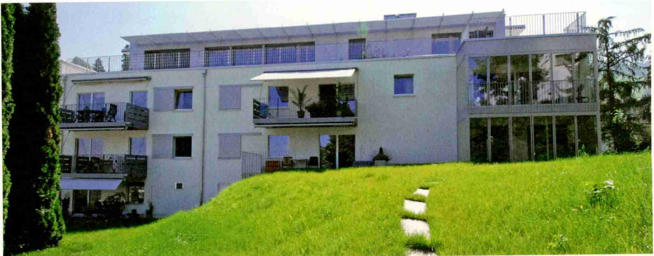
Das MFH an der Bohlstrasse 38 in Zug aus dem Kohle-Zeitalter (Baujahr 1946) wurde energetisch nach Minergie-P saniert. Energieeffiziente Systemtechnik, Photovoltaik und Solarwärmekollektoren machen es zum emissionsfrei betreibbaren Plusenergiegebäude. (Bilder: Miloni Solar AG)
