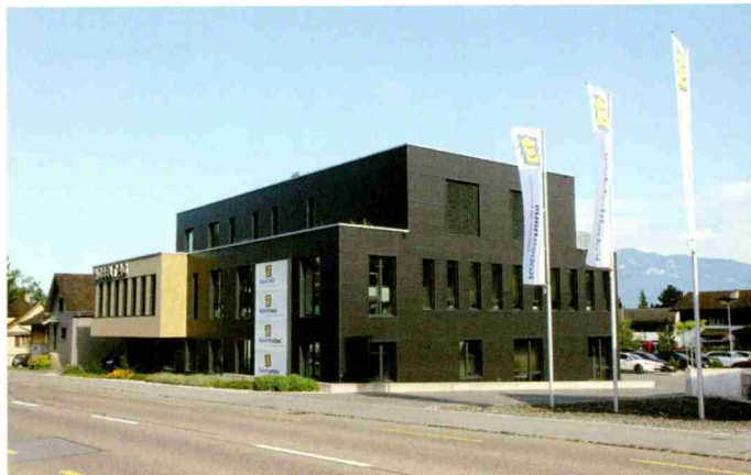
Kobelthaus-Hauptsitz in Marbach, erbaut nach Minergie-P-Standard.
