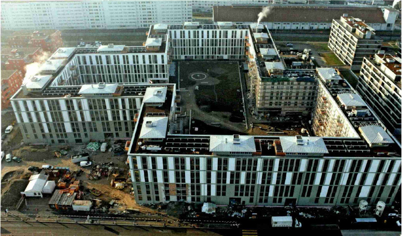
Ein Studie über zwei Lüftungskonzepte in der neuen Siedlung Klee am Stadtrand von Zürich löste in der Fachwelt eine kontroverse Diskussion über kontrollierte Lüftungen aus.
