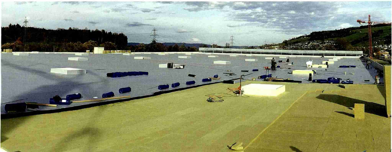
Flachdach-Wärmedämmung erfolgt heute in unterschiedlichen Dimensionen, wie das Beispiel bei einer Produktionshalle von Sika zeigt. (Bild: Flumroc AG)
