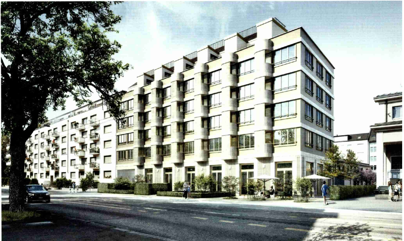
Das neue Wohnhaus an der Hohlstrasse schliesst eine Siedlung aus den 1930er-Jahren ab und weist zugleich in die Zukunft.
