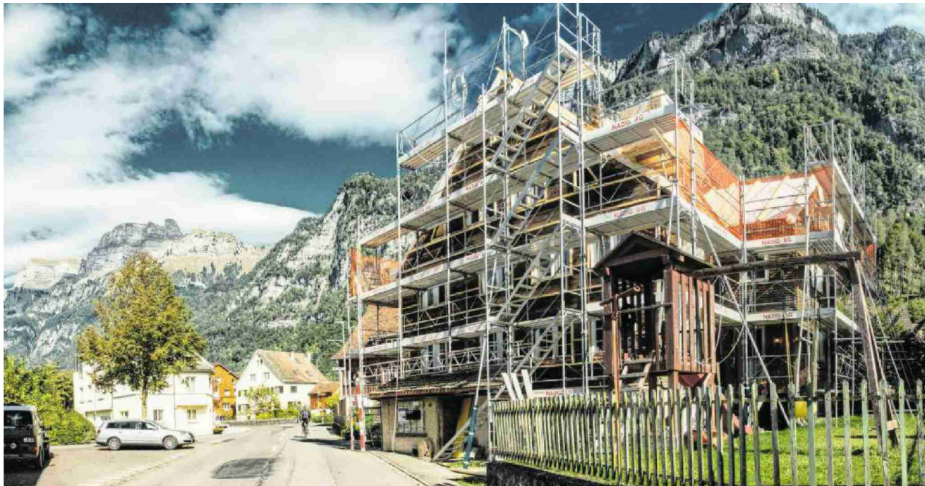
70 Prozent der Wärmeverluste eines Gebäudes gehen durch die Aussenwände: Renovation in Berschis, Walenstadt (SG).
