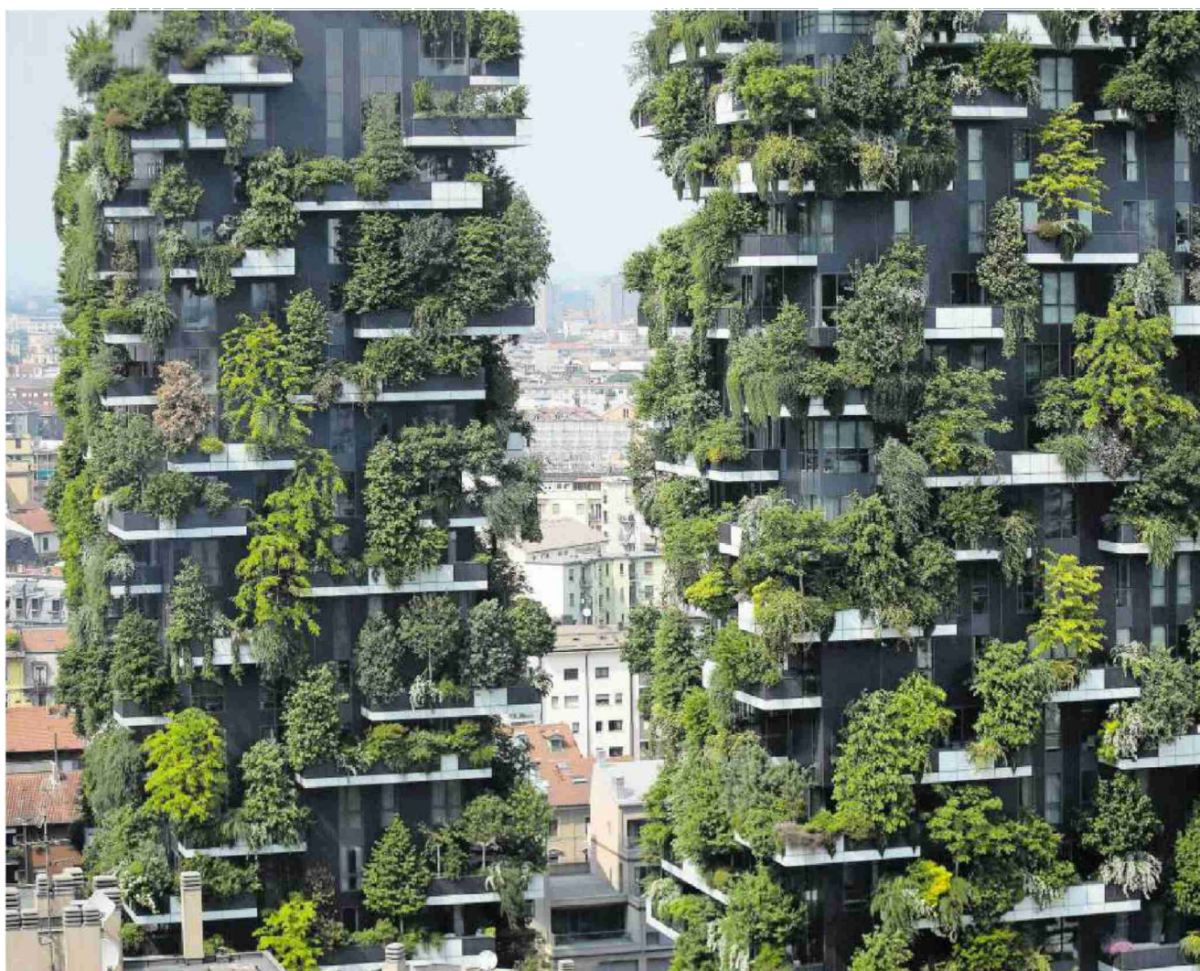
Begrünte Fassaden wie bei der Siedlung Bosco Verticale in Mailand können ein Mittel gegen Hitze sein.
